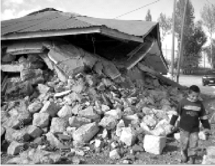
Şekil 6. Alaköy'de yıkılan yapılar
