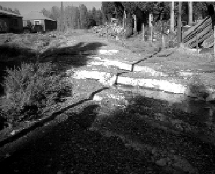
Şekil 4. Yanal yayılma dolayısıyla yolda görülen deformasyonlar.
