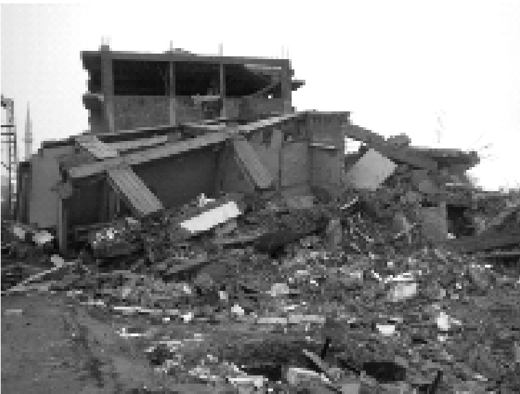
Şekil 1. Erciş ilçesinde yıkılan bir bina
